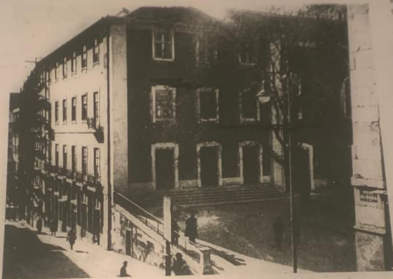
Edifício da Boa Hora
