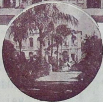
Instituto Internacional de Investigações Científicas, fundado em em 1917, na cidade de Calcutá, pelo Dr. Bose. Em cima, a entrada principal; em baixo, a parte posterior do Estabelecimento e os jardins de recreio
